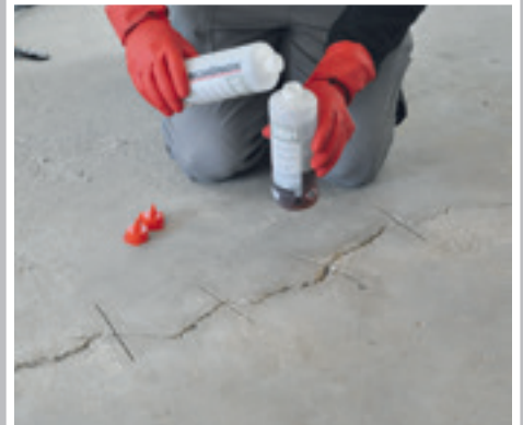
Component B bij component A gieten; sluiten en min. 15 sec. schudden
